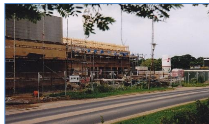
Opbygningen er i fuld gang.
